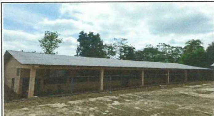
Foto1: SUSTITUCION DE CUBIERTA DE LAMINA POR LAMINA TROQUELADA
